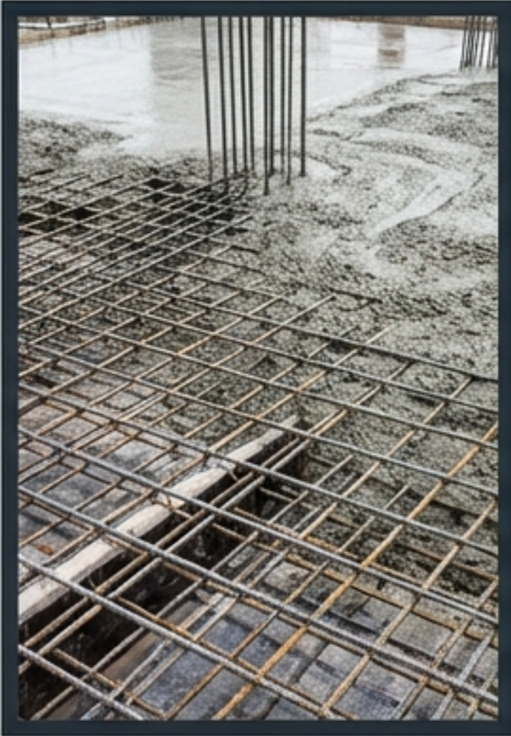
1. Obra Civil y Estructural
